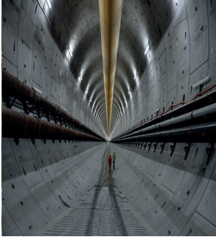
Avrasya Tüneli Tüp Geçit Projesi (Yapı Merkezi)
